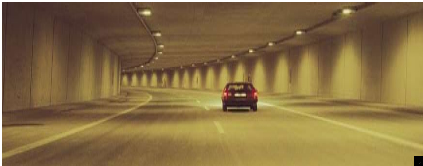
Тоннель Birth-Velbert, Германия. 1: пороговая зона. 2 и 3: переходные зоны.
