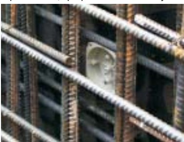
Крышка KBV, прикрепленная на опалубке.
