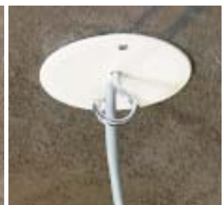
Коробка KBT... закрытая крышкой V 68 S с выведенным проводом и люстровым крюком KBP...
