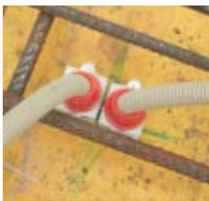
Пример использования концевых втулок и наконечников.
