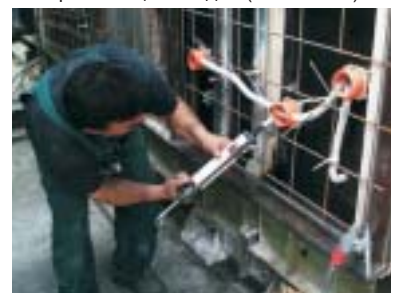
Герметизация вводов (шпатлёвка).
