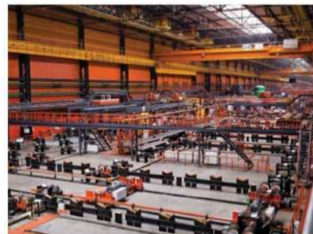
Внутри производственных цехов Опоры внутренних коммуникаций для подключения оборудования
